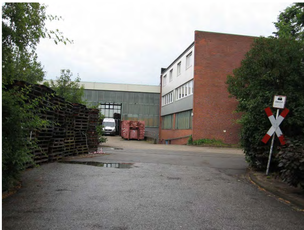
Foto 24: Blick auf die westlich anschließende Werkstatthalle (Schumacherwerder 1)
