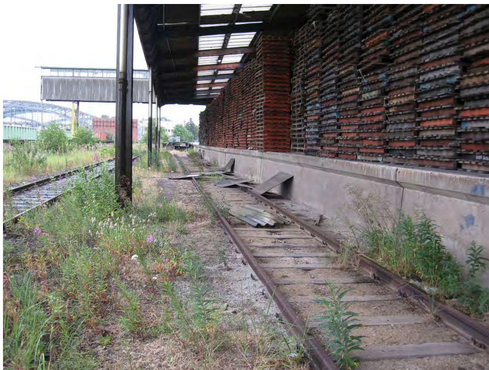
Foto 4: Gleise nördlich des Hallenkomplexes (Blickrichtung Ost)
