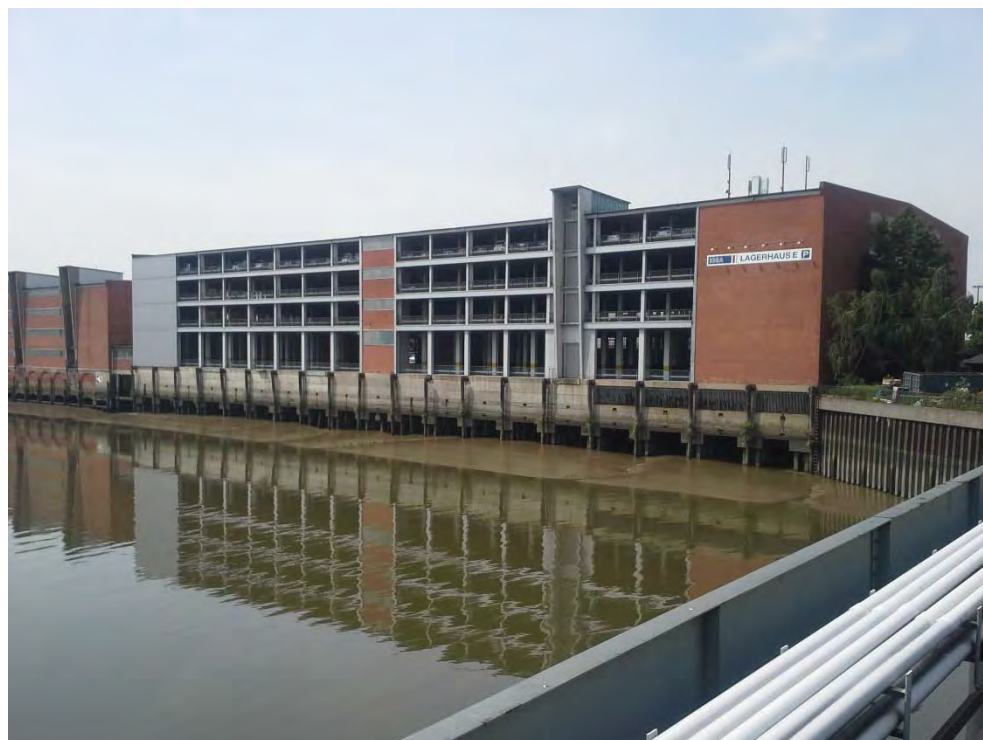
Foto 3: Lagerhaus E am Dessauer Ufer (Ostansicht)
