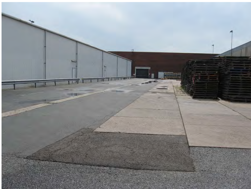
Foto 15: Fahrstraße und Stellflächen zwischen den Hallen
