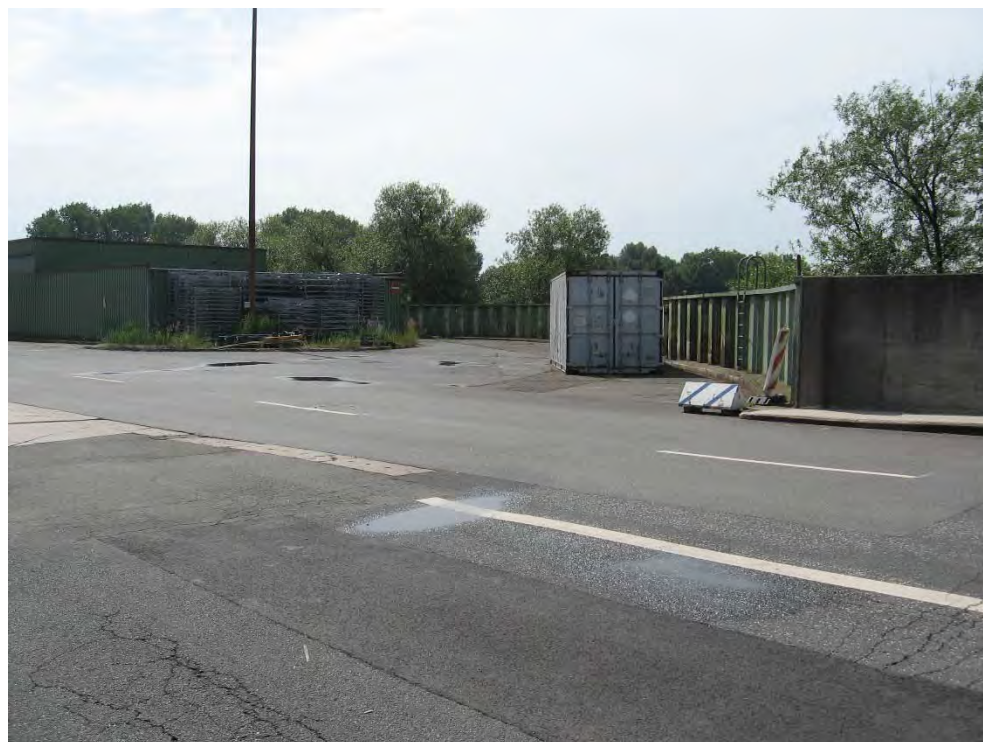
Foto 22: Zentrale Sprinkleranlage (links) und HWS-Wand am Prager Ufer (rechts)
