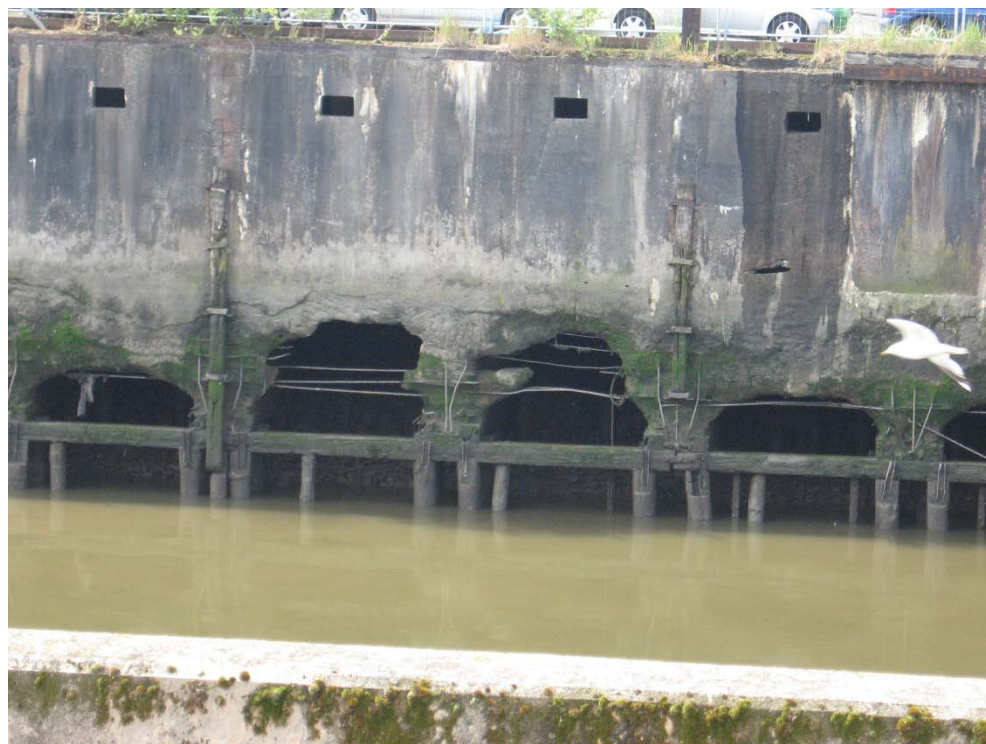
Foto 11: Uferbefestigung im Bereich des ehemaligen Lagerhauses C
