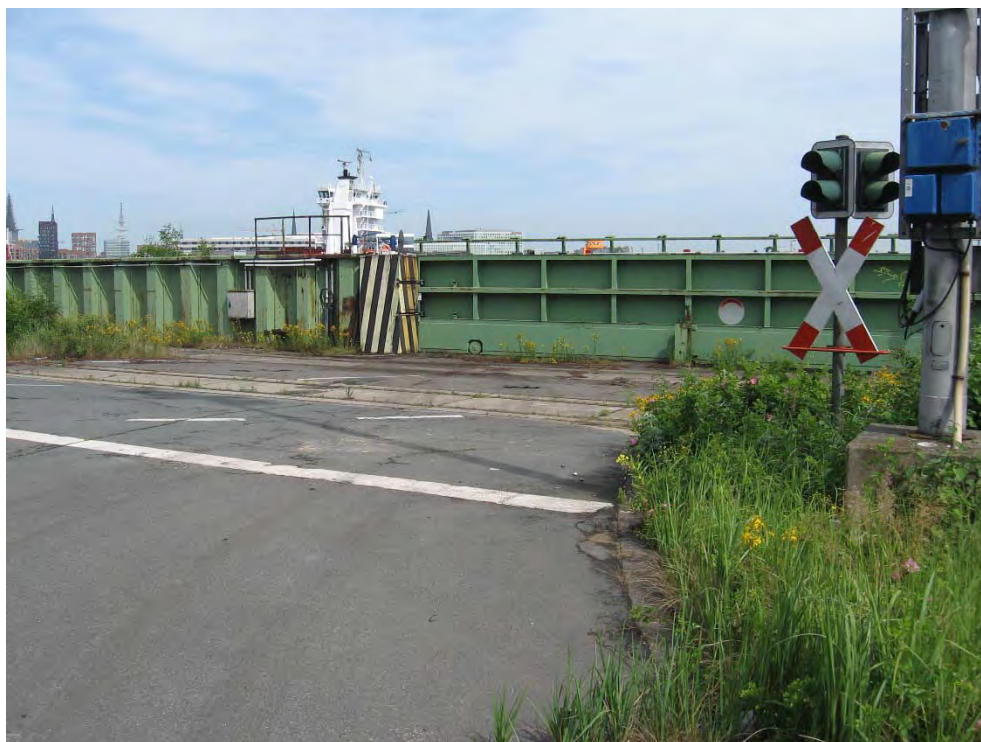
Foto 18: Bahnübergang und Flutschutztor zum Holthausenkai (Blick Richtung N)
