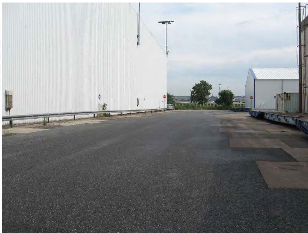
Foto 14: Fahrstraße zwischen den Hallen (Blickrichtung Nord)
