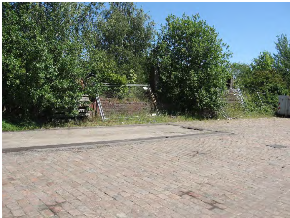
Foto 15: Relikte des ehemaligen Lagerhauses A an der Asiastraße
