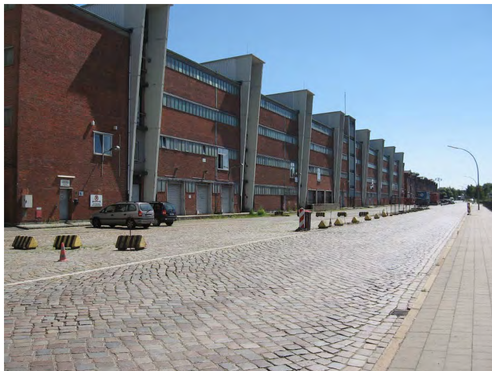
Foto 6: Lagerhaus F an der Dessauer Straße (Blickrichtung Süd)
