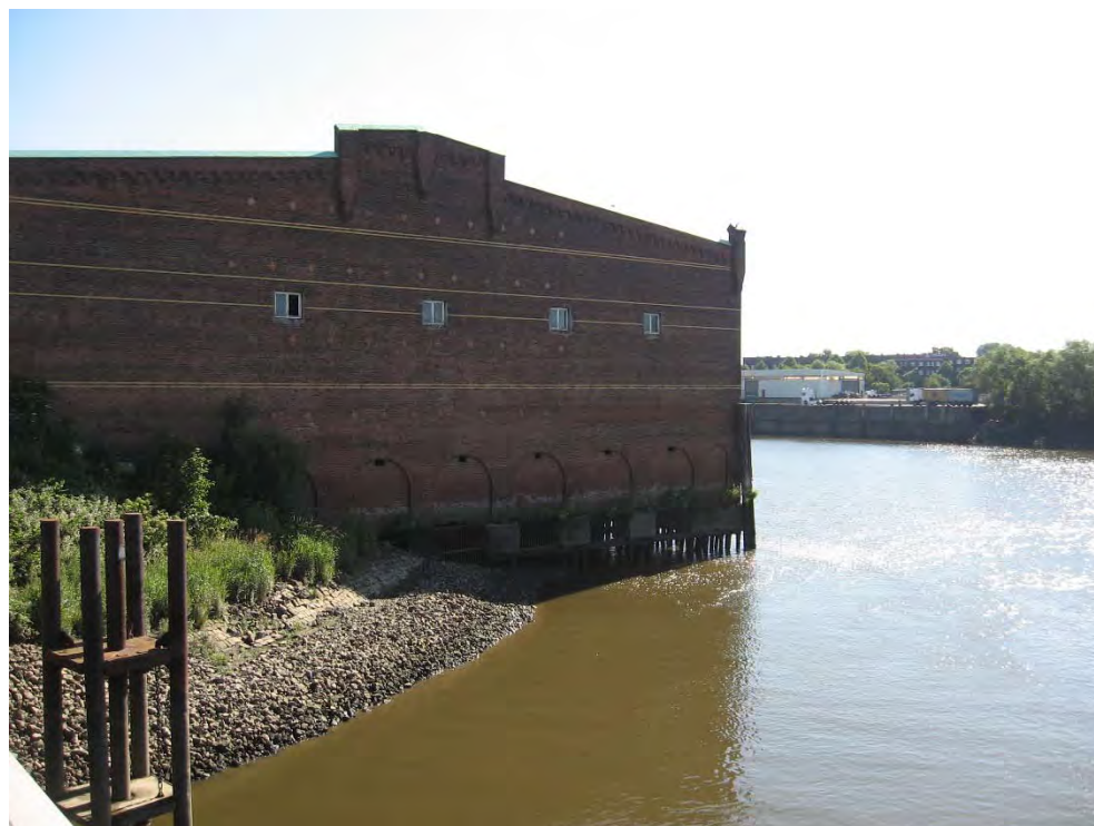
Foto 4: Blick von der Hansabrücke auf das Lagerhaus G (Südseite)
