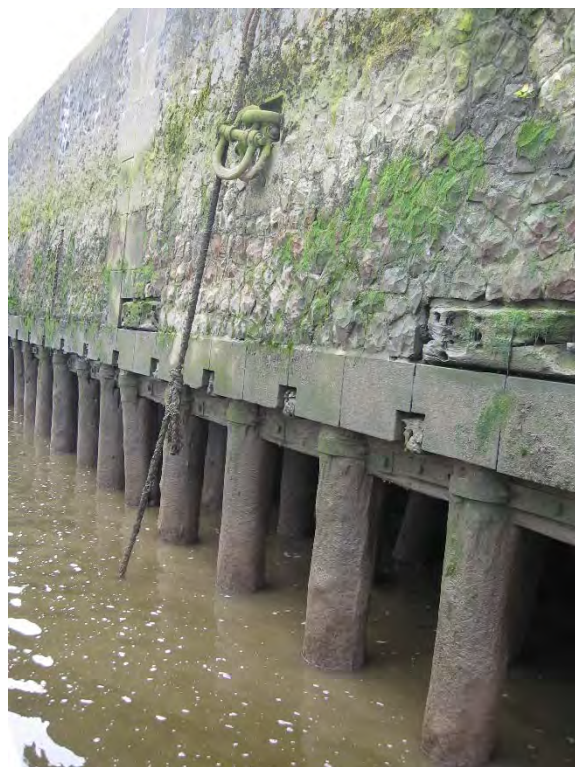
Foto 28: Auf Holzpfählen aufgesetzte Uferwand aus Basalt (Anleger Holthusen kai)
