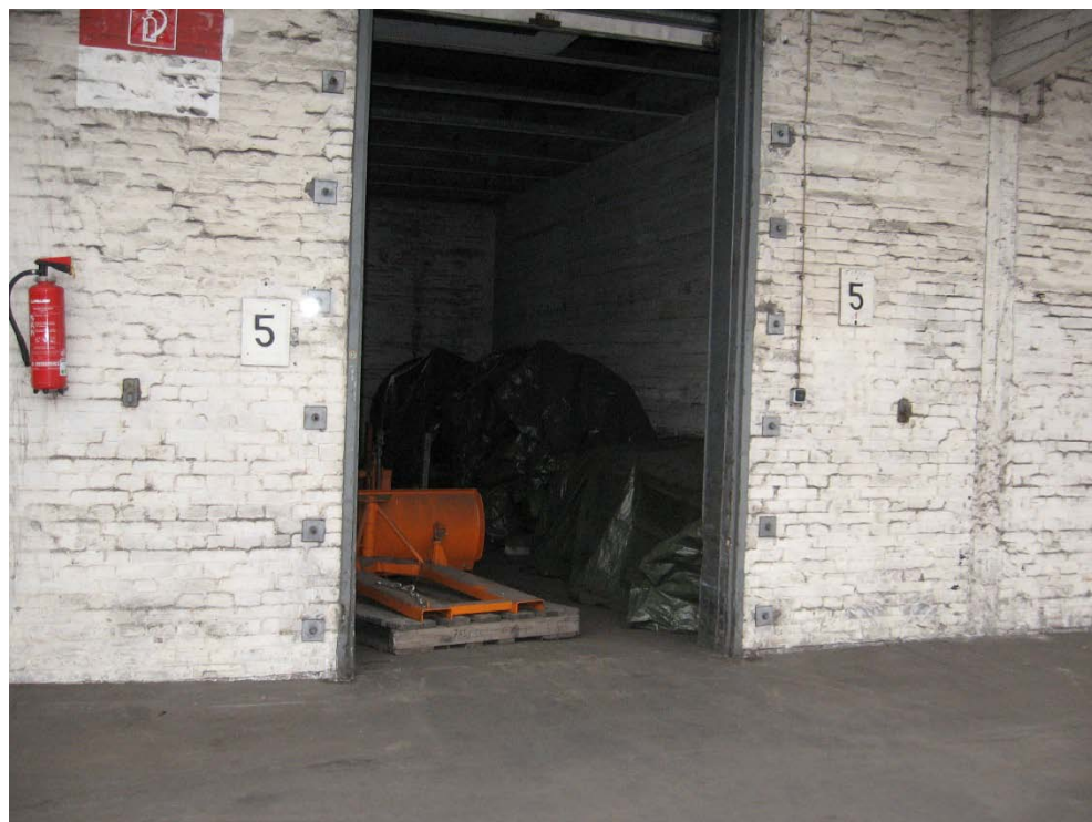
Foto 8: Ehemals Lagerraum für gefährliche Güter
