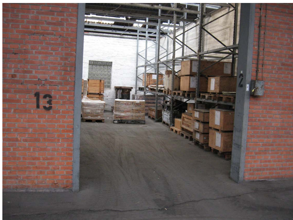
Foto 7: Ehemals Lagerraum für gefährliche Güter
