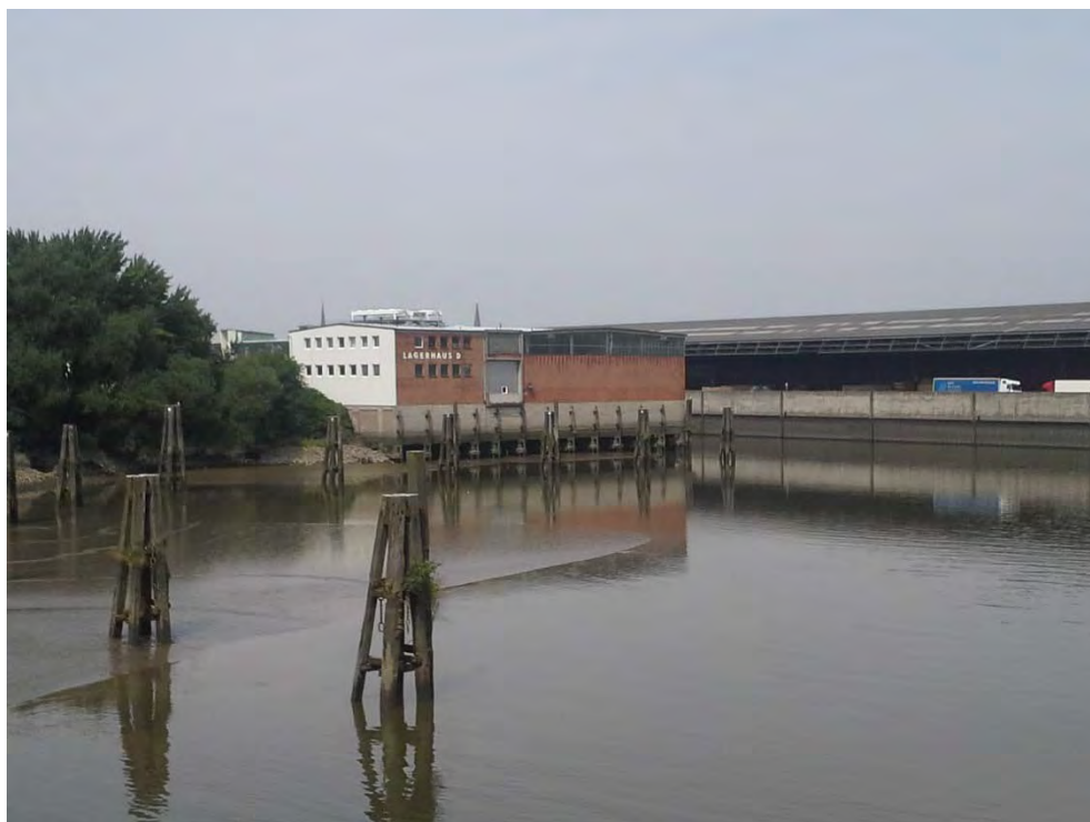
Foto 1: Blick von der Sachsenbrücke auf die Ostseite des Lagerhauses D
