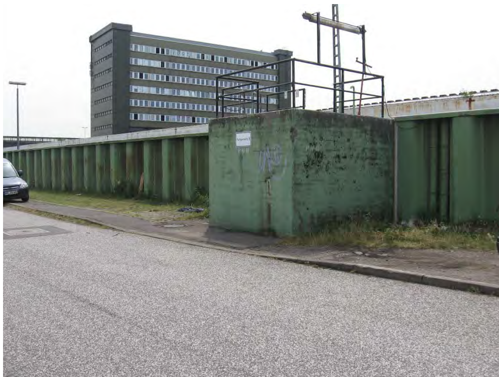
Foto 29: Hochwasserschutzwand mit Pumpwerk (südlich Straße Am Holthusen kai)
