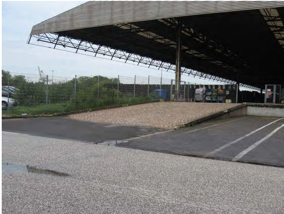
Foto 11: Rampenzufahrt nordöstlich des Hallenkomplexes
