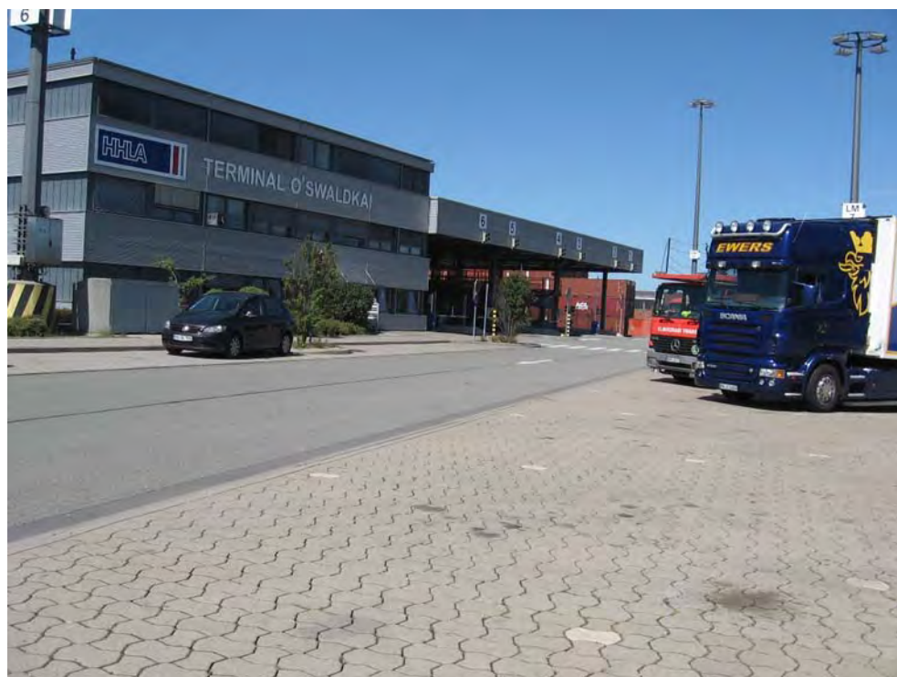
Foto 16: Fahr- und Stellflächen vor bzw. östlich des Terminalgeländes O'Swaldkai
