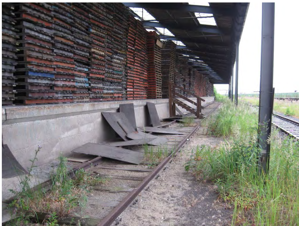
Foto 3: Gleise nördlich des Hallenkomplexes (Blickrichtung West)
