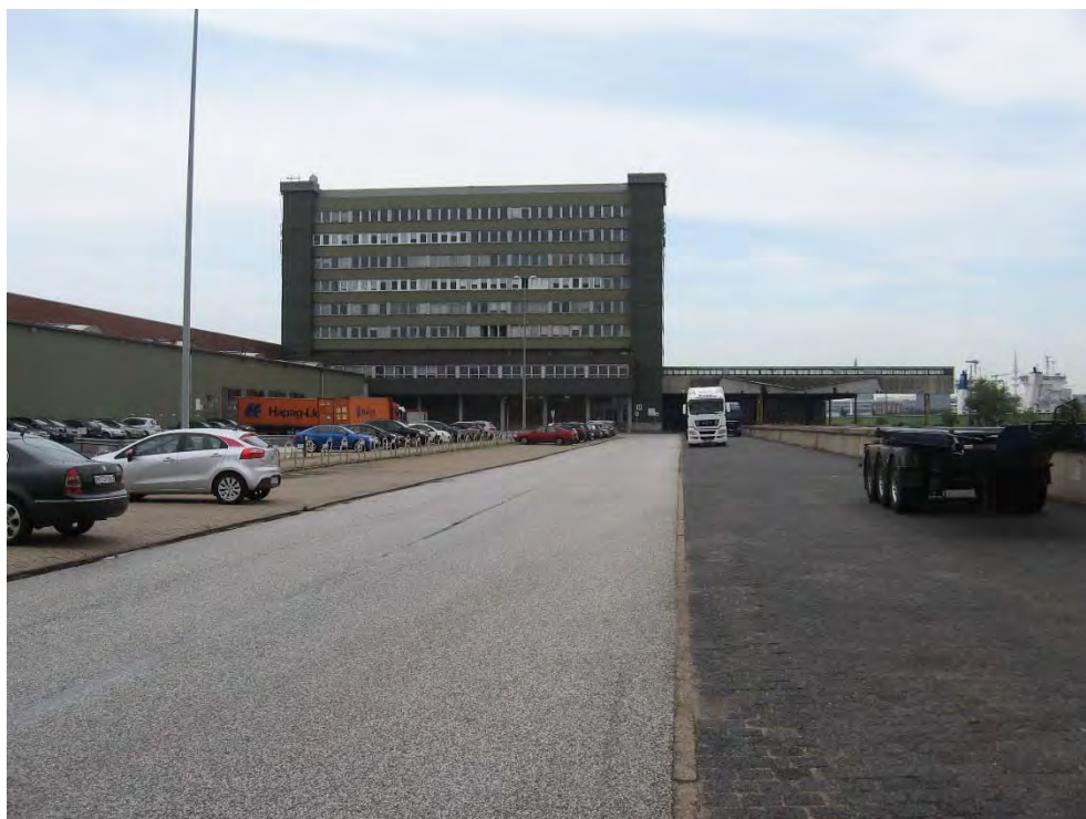
Foto 1: Blick von der Straße Schumacherwerder auf das Verwaltungsgebäude
