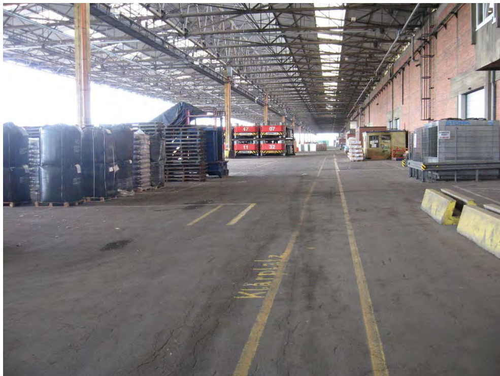
Foto 12: Überdachter Verladebereich östlich des Hallenkomplexes (Blickrichtung S)
