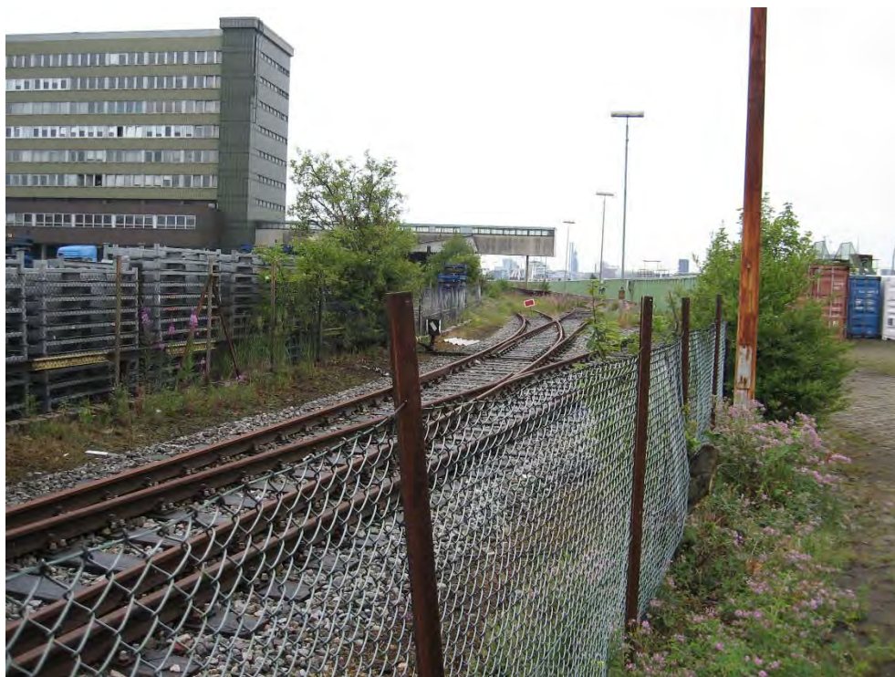
Foto 2: Gleisanlagen südlich der Werkstatt am Schumacherwerder 1
