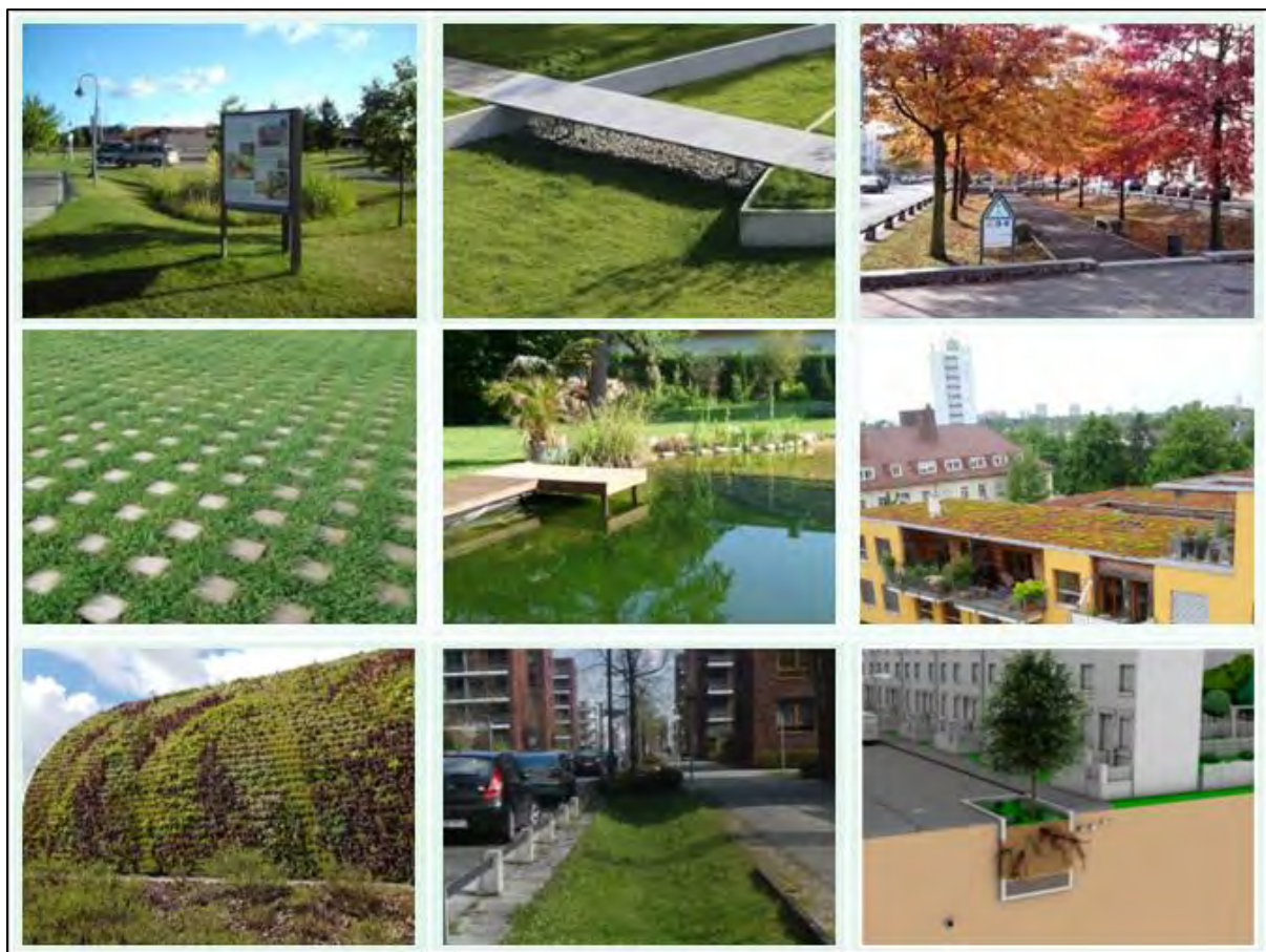
Abbildung 18: Optionen der dezRWB für eine Schwammstadt, Symbolbilder Mulden, Baumrigolen, Teiche, durchlässige Beläge und Gründächer
