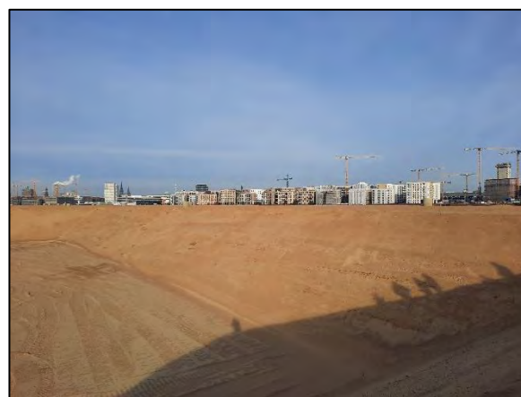
Abbildung 4: Moldauhafenquartier im Zuge der Herstellung des Warftniveaus
