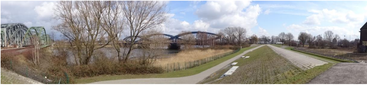
Abbildung 4: Elbufer mit Ausgleichsflächen sowie Hochwasserschutzdeich in Veddel-Nord
