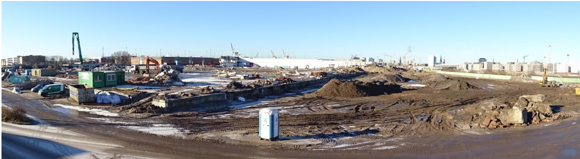
Abbildung 2: Flächenräumung im Bereich des ehemaligen Überseezentrums im Januar 2022
