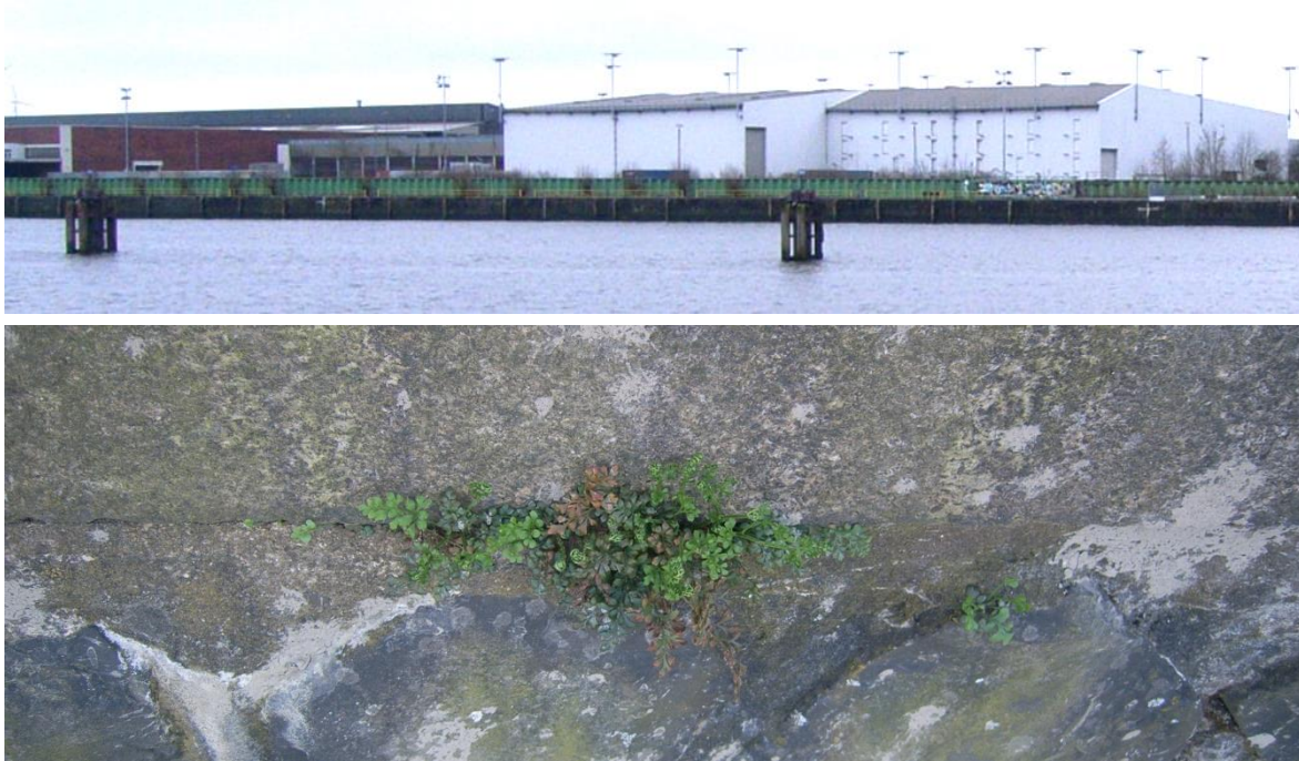
Abbildung 8: Kaimauer aus Natursteinen im Nordwesten des Überseezentrums (Elbseite) und Detail mit Mauerraute
