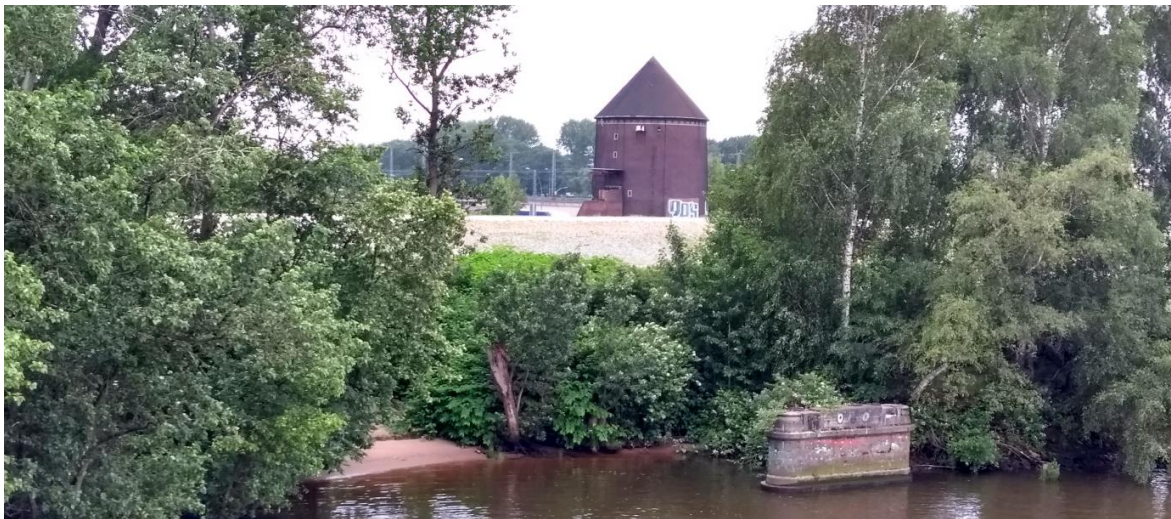
Abbildung 10: Blick auf den Turmbunker mit Nisthilfe für Turmfalken, im Vordergrund ein kleiner Flussstrand an der Elbe
