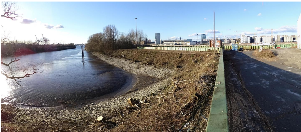
Abbildung 3: Flächenräumung für die zukünftige Moldaubrücke, nördlicher Bereich am Veddelhöft
