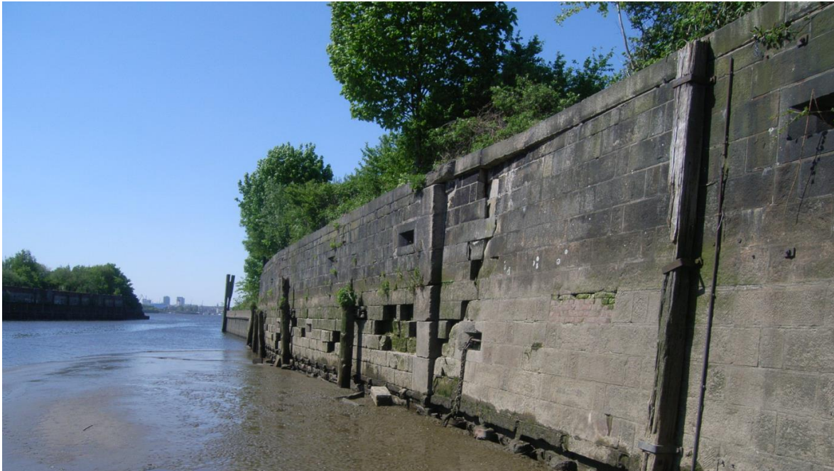
Abbildung 9: Kaimauer aus Großblöcken im Südwesten des Überseezentrums am Moldauhafen
