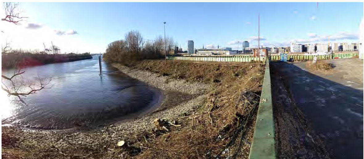
Abbildung 4: Flächenräumung für die zukünftige Moldaubrücke, nördlicher Bereich am Veddelhöft
