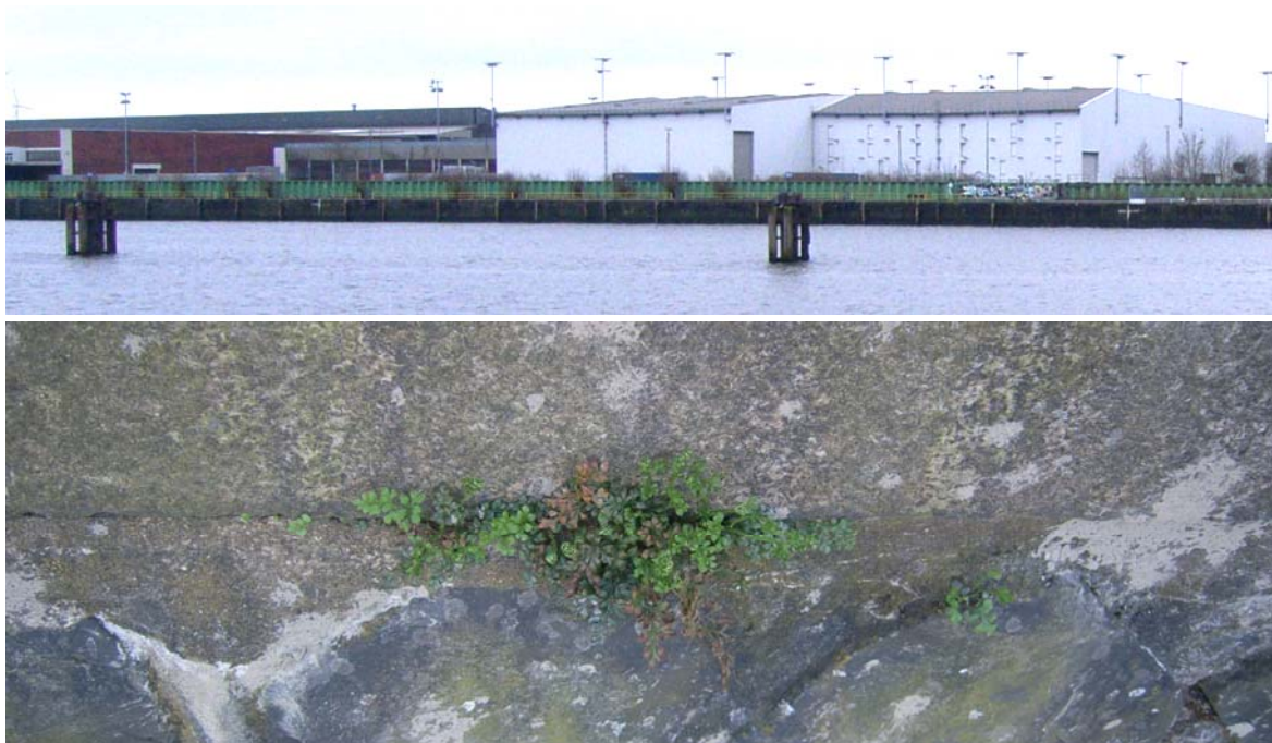
Abbildung 5: Kaimauer aus Natursteinen im Nordwesten des Überseezentrums (Elbseite) (oben: von der Elbe aus gesehen, unten: Detail mit Mauerraute)
