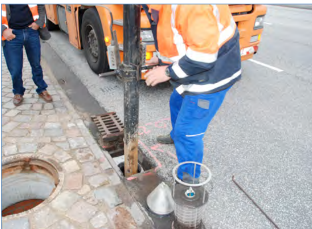
Abb. 73: Reinigung einer Trumme
