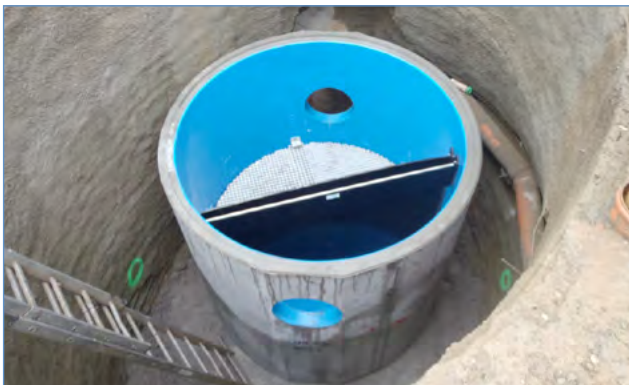
Abb. 35: Filterschacht
