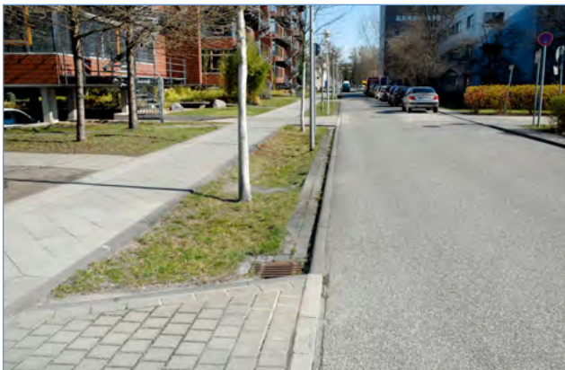
Abb. 24: Versickerung der Gehwegabflüsse in Rigolen
