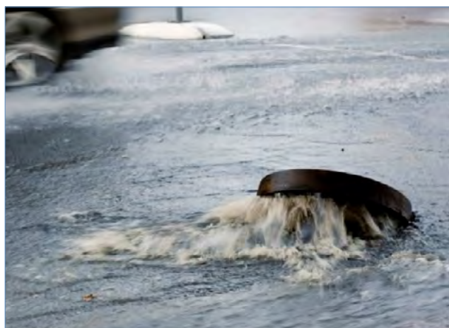
Abb. 4: Sielüberstau als Folge eines Starkregenereignisses
