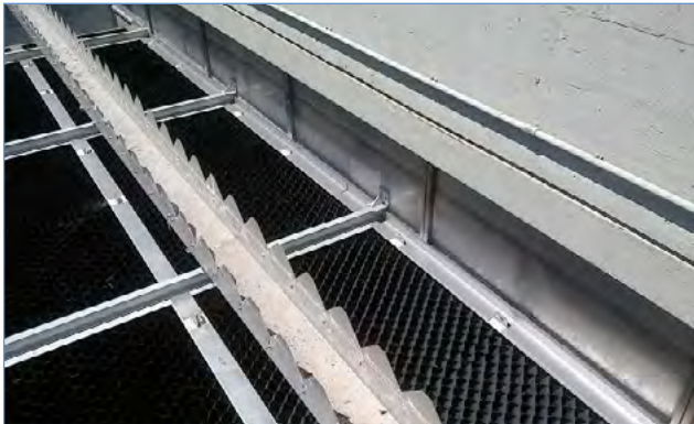
Abb. 32: Lamellenabscheider
