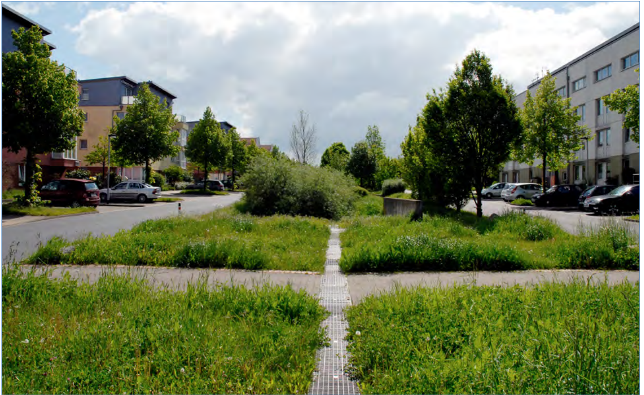
Abb. 30: Großflächige Versickerungsmulden im Mittelstreifen
