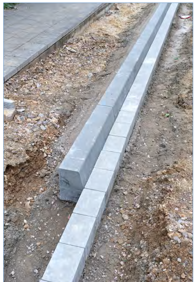
Abb. 36: Grundinstandsetzung einer Straße
