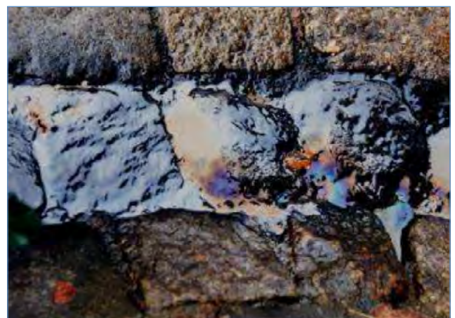
Abb. 3: Schadstofffahne im Straßenabfluss
