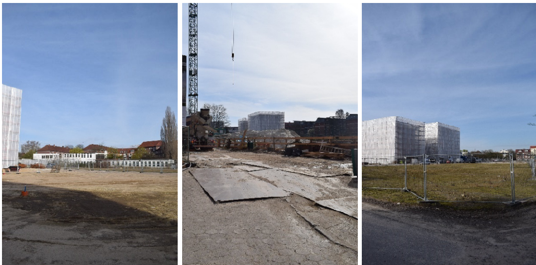
Abb. 11-13: Zentrale Fläche mit KFZ- Werkstatt; Neubau südlich St. Sophien; Neubau zentrale Fläche Südost
